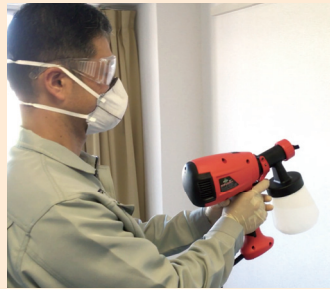
電動噴射機による塗布の様子。 40㎡の塗布の場合、作業時間は およそ10分ほどです。
